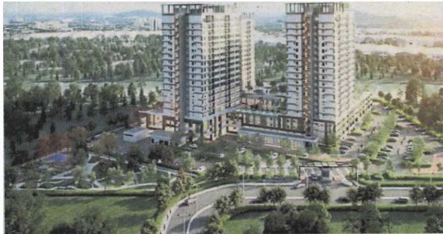
拥有 646 个永久地契公寓的 The Greens@Subang West。
